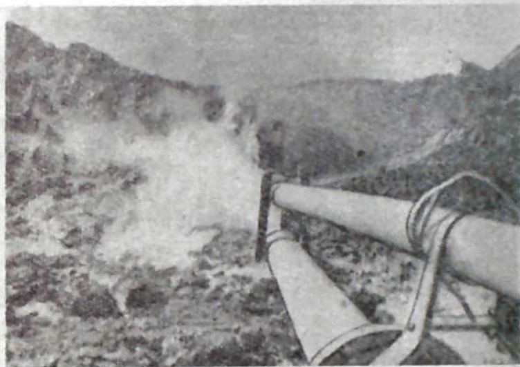
Рис. 2. Ермолаевский угольный разрез. Вскрыша породы гидромониторами. Фото М. Маркелова.
