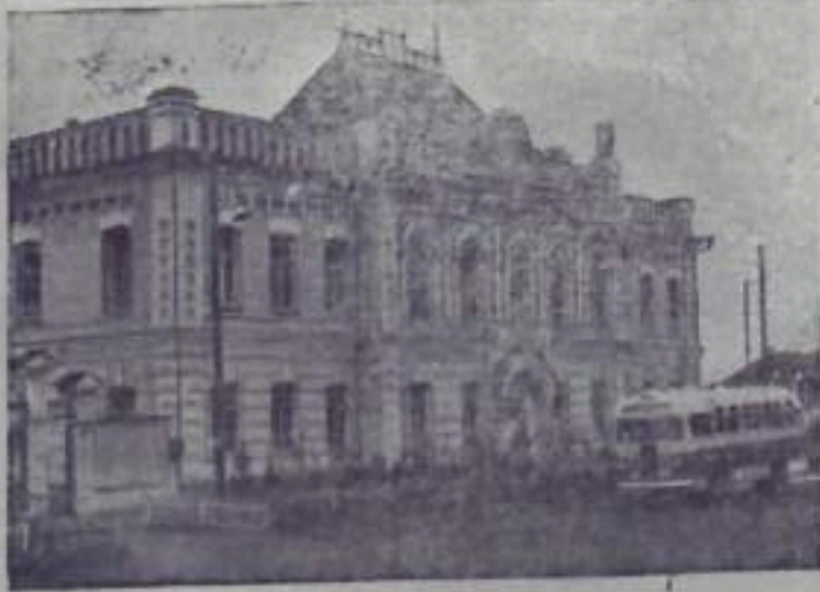
Якутск. Здание Верховного Совета Якутской АССР. Фото А. Фалко. Проспекты ТАСС.
