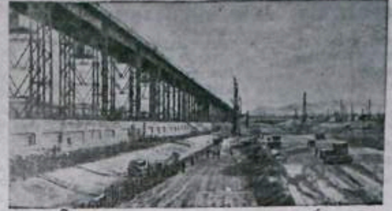
Куйбышевгидрострой. На участке строительства водосливной плотины.
