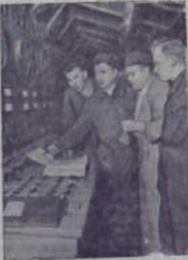
В Варшаве заканчивается строительство первой очереди крупнейшей в Польской Народной Республике теплоэлектростанции «Жерани». Она сооружается по советским проектам и полностью оснащается советским оборудованием.
