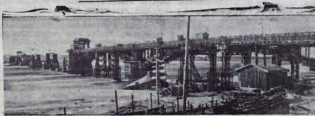
В Нижне-Волжске строится мост через реку Обь. Он свяжет левобережный промышленный район с центром города. Над поверхностью реки уже поднялись высокие опоры нового моста. В них уложено свыше 44 тысяч кубометров бетона и железобетона. Смотрительно большое количество металлических конструкций.
