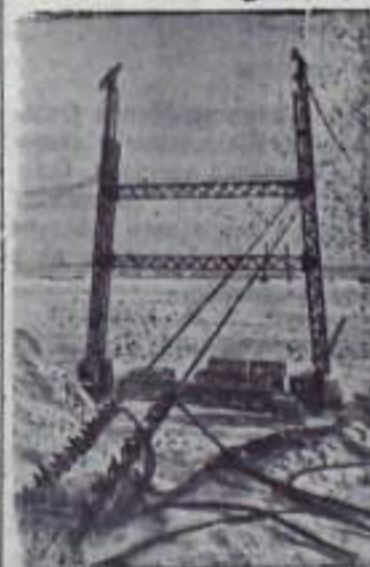
СТАЛИНГРАДСКОПРОСТРОЙ. В районе строительства Сталинградской ГЭС сооружается подвесная канатная дорога. На берегу Волги устанавливается металлоконструкция опор подвесной дороги: их высота — 132 метра. На снимке: установка металлоконструкций на правом берегу Волги.
