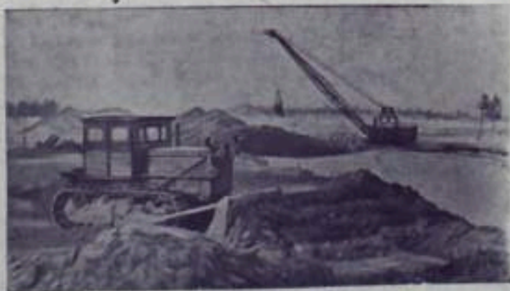
В Новосибирской области на реке Обь строится крупная гидроэлектростанция. Она даст электроэнергию фабрикам, колхозам МТС и совхозам Западной Сибири. НА СНИМКЕ: один из участков строительства верхнего подводящего канала плотины. Фото В. Лавдинского.
