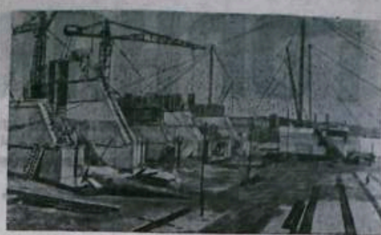
Молдавская ССР. Недалеко от районного центра Дубоссары на реке Днестр строится первая в Молдавии гидроэлектростанция. Уже возведена водосливная плотина, заканчивается сооружение здания электростанции, монтируются турбины. Выстроены поселок с клубом, школой, столовыми, магазинами, поликлиникой. Дубоссарская ГЭС будет обслуживать 14 районов и 5 городов и даст электроэнергии больше, чем теперь ее дают все станции республики. Около 40 процентов энергии новой станции предназначается для нужд сельского хозяйства.
