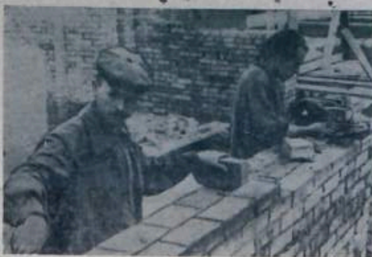
В Кумертауском строительном управлении каменщики бригады т. Кищенко в этом году выработали 14 месячных норм. НА СНИМКЕ: бригадир т. Кищенко (слева) и каменщик т. Шушманов ведут кирпичную кладку стены на здании горкома партии.
