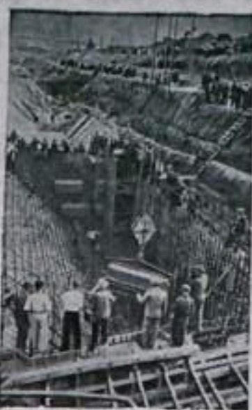
На строительстве Сталинградской ГЭС начато сооружение здания гидроэлектростанции. В основании здания уложены первые кубометры бетона.
