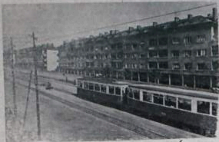
Народная республика Болгария. В столице республики Софии развернулось строительство жилых домов. НА СНИМКЕ: новостройки на бульваре имени Стамболийского. Фото болгарского телеграфного агентства.
