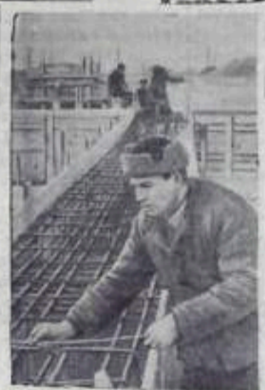
УКРАИНСКАЯ ССР. На строительстве Кременчугской ГЭС начато сооружение бетонного завода производительностью 800 тысяч кубометров бетона в год. Хорошо трудится здесь бригада плотников Г. И. Вирича. НА СНИМКЕ: бригадир плотников Г. И. Вирич.
