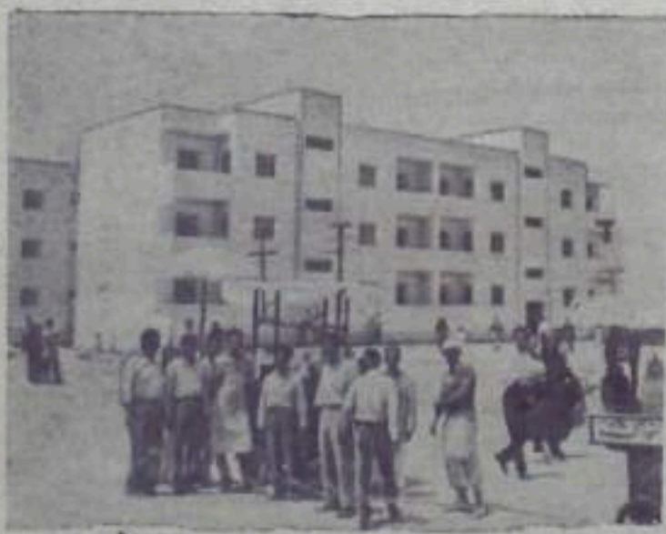
Пост-Сид. В южных частях французской территории южные здания в городе были разрушены авиационными бомбами. Сразу же после освобождения разрушенные здания восстанавливались. Были восстановлены здания, построенные местными, и возведены
