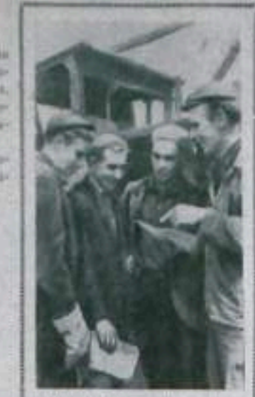
Ремонт. Сотни молодых и деловых бригад на стройке Рыбинского гидроэлектростанции...
