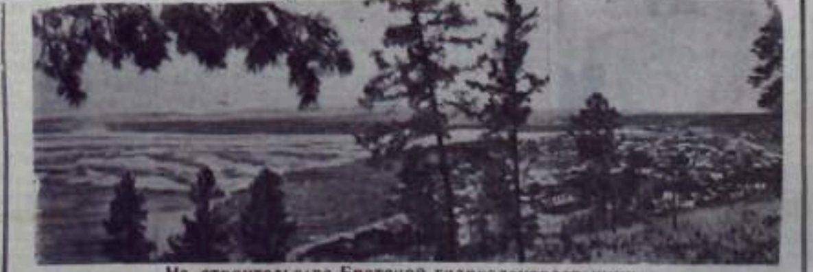
На строительстве Братской гидроэлектростанции. Общий вид временного поселка строителей Цадуи. Слева—Цадуинский порог.
