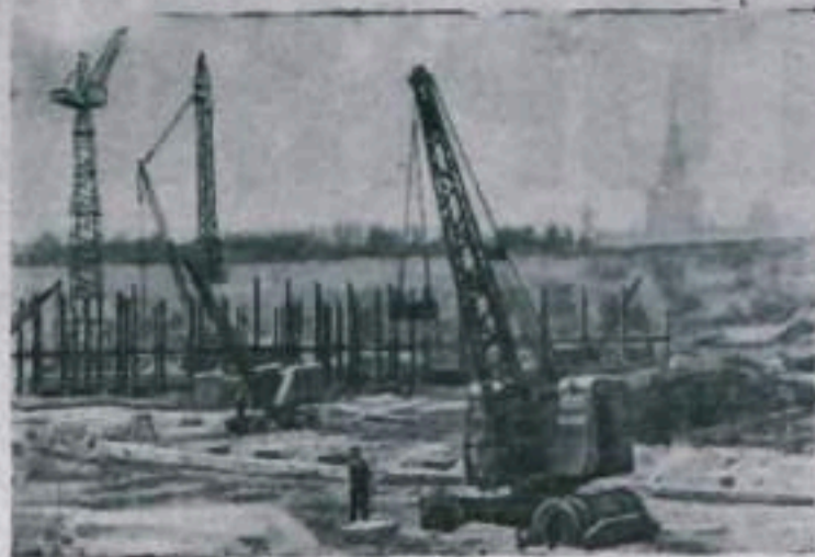
Москва. В Лужниках, на месте бывших пустырей и огородов, развернулось строительство нового столичного стадиона. Огромный объем работ предстоит выполнить строителям спортивного сооружения. Только на трибуны главной арены пойдет свыше четырех тысяч тонн стальных конструкций. Здесь будет уложено свыше 12 миллионов штук кирпича и более 20 тысяч кубометров бетона.
