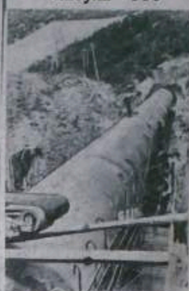
ГРУЗИНСКАЯ ССР. Строительство Тибули ГЭС вступило в предпусковой период. Закончено сооружение 2 500-метрового туннеля, по которому пойдет вода реки Тибули. Завершается отделка здания станции. Группа работников Ленинградского управления «Спецгидромонтаж» под руководством Г. Марченко закончила монтаж турбины и успешно ведет монтаж генератора. В сентябре этого года будут сданы четыре агрегата.
