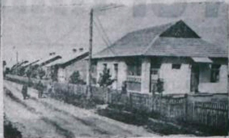
Закончено комплексное строительство Торчинской МТС. На новой усадьбе сооружены механическая мастерская, несколько гаражей для комбайнов, навесы для сельскохозяйственных машин, бензосклад и другие помещения. В удобные жилые дома вселились семьи механизаторов и специалистов сельского хозяйства, работающих в МТС.
