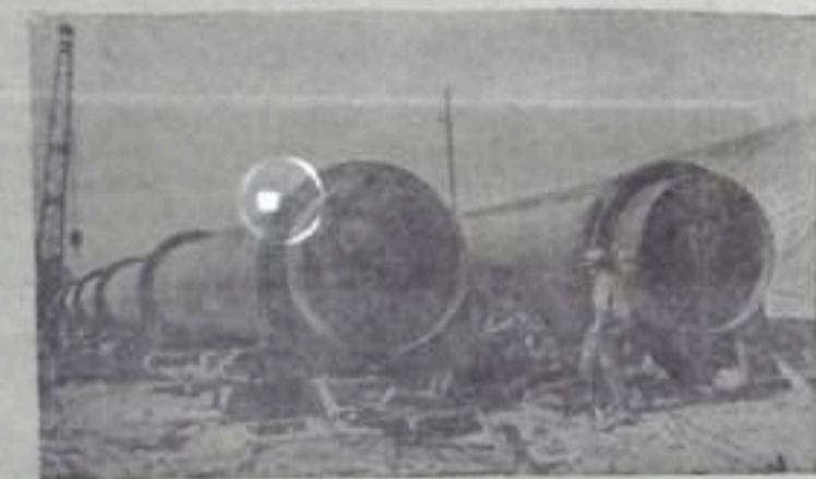
В Таджикиской ССР сооружается (Ходжа-Бакитганская) оросительная система, на которой даст вогу на Кайран-Кумского водохранилища вступившим рабочим Ленинадской области. Будет орошено около 12 тысяч гектаров. НА СНИМКЕ: монтаж трубопровода Ходжа-Бакитганской оросительной системы.
