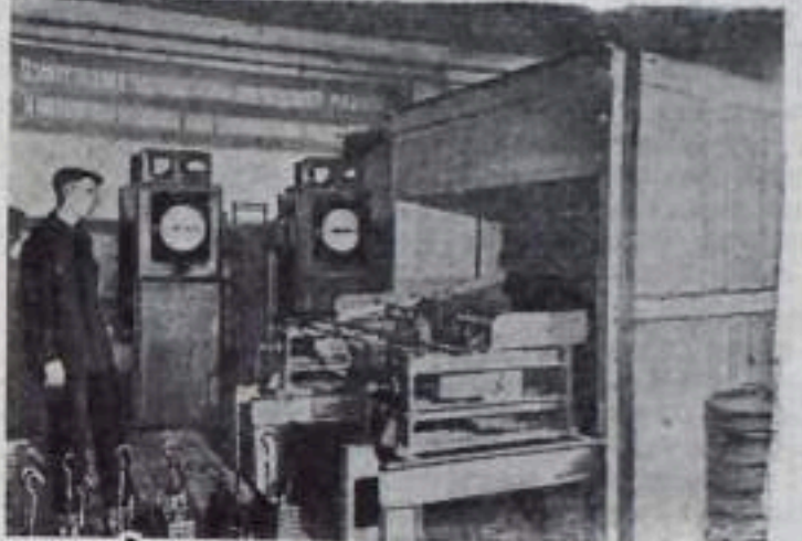
Челябинск. В термическом цехе Челябинского тракторного завода пущена в эксплуатацию полуавтоматическая линия для цинкирования деталей.
