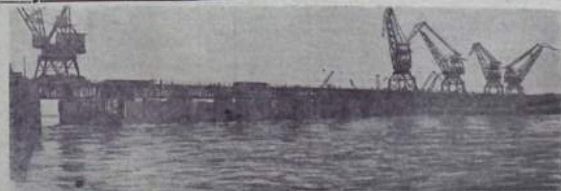
На строительстве Новосибирской гидроэлектростанции. Река Обь протекает через пролеты водосливной плотины.
