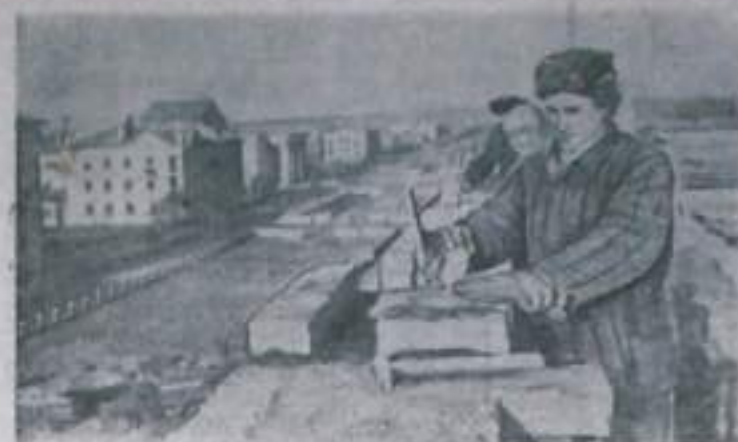
КАМЕНСКАЯ ОБЛАСТЬ. В городе Камешеве-Шахтинском на улице имени Ворошилова и проспекте Карла Маркса развернулось строительство жилых домов для рабочих комбината. Строители применяют комплексную организацию труда. За короткий срок здесь сооружено несколько четырех- и пятиэтажных домов. Комплексная бригада П. Ф. Шевченко, работавшая на строительстве 72-квартирного дома, ведет одновременно кладку стен, укладку железобетонных перекрытий, установку балконов и другие работы.
