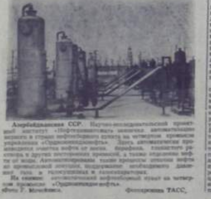
Автоматизация нефтесборного пункта. Фото Г. Бордана. Фотография ТАСС.
