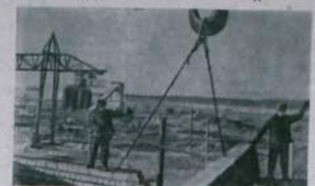
В Красноярском крае на базе железнодорожных бытовых баз строится крупная Назаровская ГРЭС. В 1961 году начнется выпуск энергии электростанции. Проектная мощность этой станции должна быть достигнута к 1965 году. Сейчас ведется промышленная база стройки. Сооружены 15 километров железнодорожных путей. В километре бетонные дорожки построены бетонный завод, полигон обожженого доломита и ряд других предприятий. Одновременно с этим начались работы на месте главного корпуса будущей ГРЭС. На снимке: общий вид строительства. Фото Ю. Барыкина. Фотохроника ТАСС.
