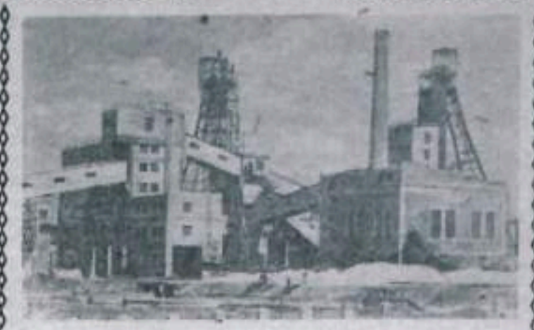
ВОРОШИЛОВГРАДСКАЯ ОБЛАСТЬ. В Кадиевском районе вступает в эксплуатацию новая шахта «Замковская» № 2. Все трудоемкие процессы здесь механизированы и автоматизированы. Шахта имеет 8 лав. Все они оснащены комбайнами «Шахтер» и транспортерами «СКТ-2». Уголь из забоев к стволу будет доставляться мощными электровозами. Проектная мощность шахты — 2 тысячи тонн угля в сутки. НА СНИМКЕ: общий вид новой шахты «Замковская» № 2.
