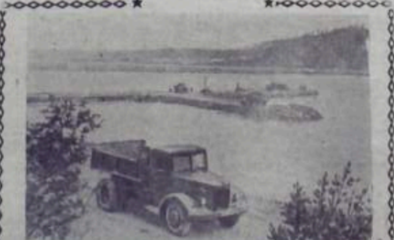
СТРОИТЕЛЬСТВО ВРАТСКОЙ ГЭС. Гидростроители упорно отвоевывают у реки место под котлован для здания ГЭС. Сейчас они ведут сооружение низовой перемычки, которая окончательно отделит участок реки от основного русла. В низовую перемычку уже отсыпано около 10 тысяч кубометров камня.
