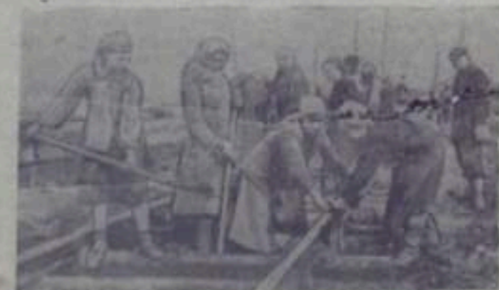
НА СНИМКЕ: передовая бригада путейцев, где бригадиром т. Шагивалов Н.
