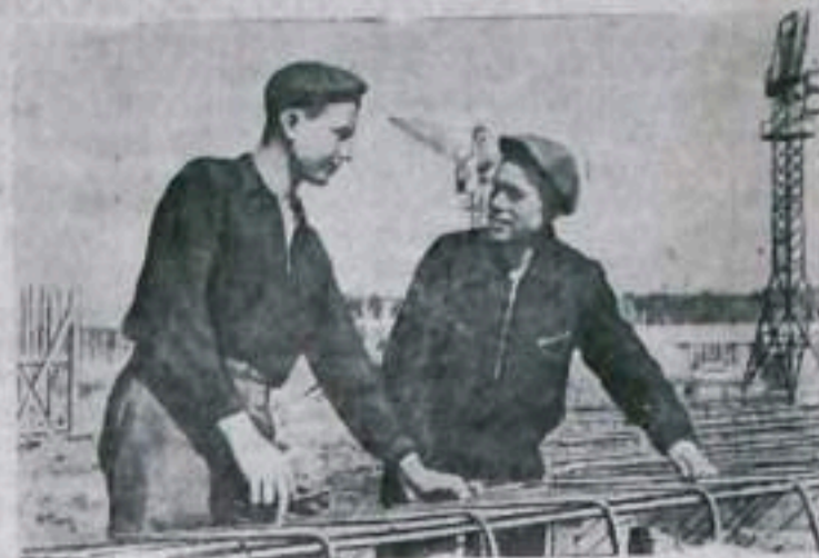
Свердловск. Недалеко от живописного озера Шарташ сооружается крупнейший завод железобетонных изделий. Комсомольцы дали слово построить этот завод на год раньше установленного срока. За успехи в социалистическом соревновании свердловской комсомольской стройки присуждено переходящее Красное знамя ЦК ВЛКСМ.
