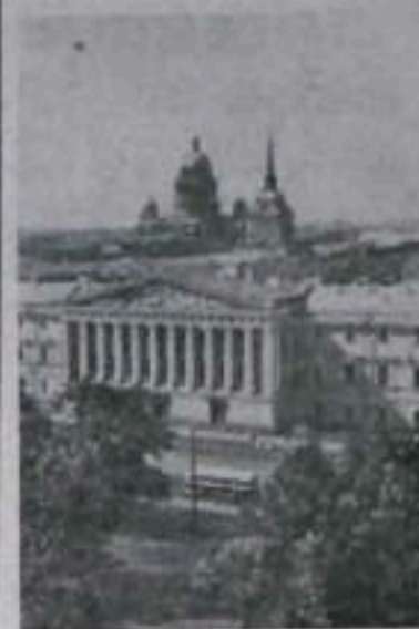
Ленинград. Вид на восточный фасад Адмиралтейства.
