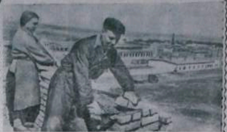
Мордовская АССР. Широкий уличный проезд созданное строительством в Саранске. Хорошо трудится комсомольская бригада комсомольцев во главе с Н. Ф. Бельяниным, строящая новую жилую зону для трудящихся города.
