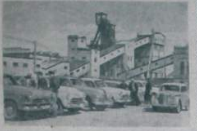
Каменск ССР. Заключено строительство Каменского завода. На снимке: строящийся завод на плане №1-го участка.
