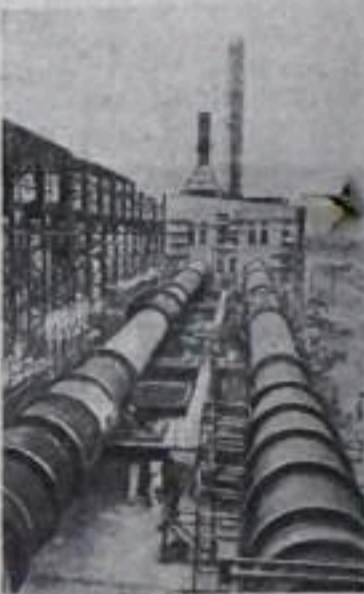
НА СНИМКЕ: цех обжига нового завода.
