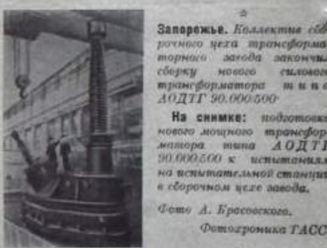
Заворезье. Коллектив сборочного цеха трансформаторного завода закончил сборку нового силового трансформатора...
