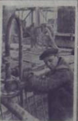
Волжская область. Западнее Свердловска строится завод по производству высококачественного стекла № 9 «Горнолышского» Литейно-Химического управления БССР.
