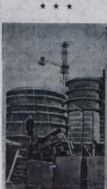
Челябинск. На строительстве 5-й комсомольской домны металлургического завода в феврале все участки перевыполнили план. С начала строительства проделана большая работа: вынута 205 тысяч кубометров земли, уложено 14,7 тысяч кубометров железобетона, смонтировано 1600 тонн металлических конструкций, проложено 12 километров железнодорожных путей.
