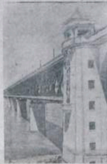
КИТАЙСКАЯ НАРОДНАЯ РЕСПУБЛИКА. Заключилось строительство в крупнейшего в Китае моста через реку Янцзы. Новый мост длиной 1700 метров имеет два яруса: нижний железнодорожный ярус и верхний — автомагистраль. Под мостом могут проходить суда водоизмещением в 10 тысяч тонн.
