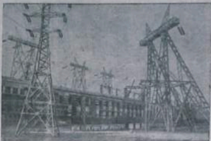
КУЙВЫШЕВСКАЯ ОБЛАСТЬ. К 40-летию Великой Октябрьской социалистической революции вступила в строй Куйбышевская ГЭС — крупнейшая электростанция в Европе. НА СНИМКЕ: здание Куйбышевской ГЭС. Фото С. Преображенского. Фотохроника ТАСС
