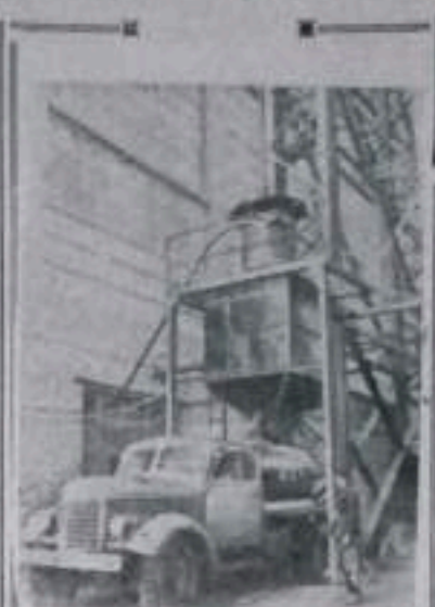
ЯРОСЛАВЛЬ. На теплоэлектростанции Ярэнерго сооружена первая промышленная установка по производству торфозольного цемента.
