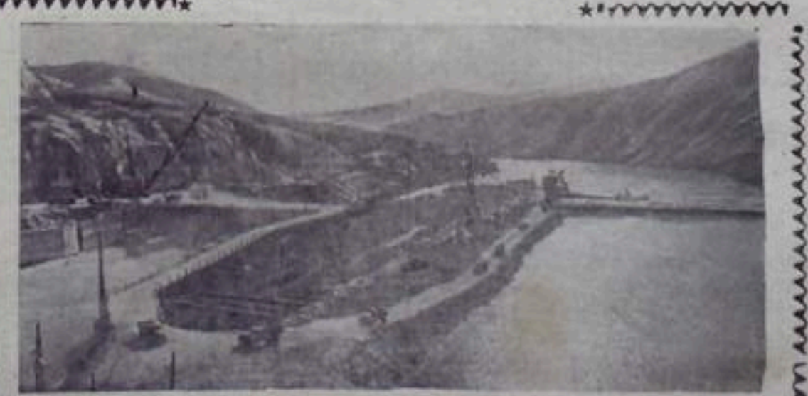
ВОСТОЧНО-КАЗАХСТАНСКАЯ ОБЛАСТЬ. Строители Бухтарминской ГЭС одержали большую трудовую победу. Досрочно затоплен котлован первой очереди и перекрыт Иртыш.
