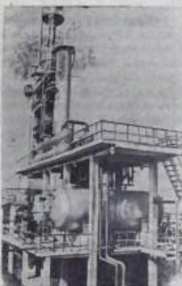
Татарская АССР. Недалеко от Альметьевска закончено строительство первого в республике газобензинового завода. По специально предложенным подземным трубопроводам газ, переработанный в резах завода, пойдет на промышленные предприятия и в квартиры трудящихся Козьмо, Бузульми, Альметьевска и других городов республики. Предприятие будет вырабатывать также бензин и жидкий газ. НА СНИМКЕ: одна из установок нового газобензинового завода.
