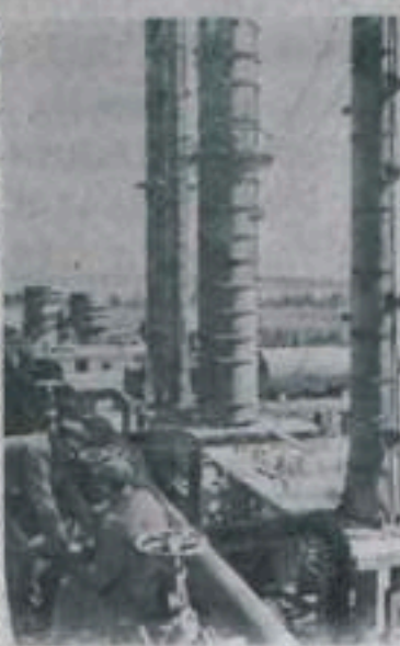
ИРКУТСКАЯ ОБЛАСТЬ. На берегу Ангары, недалеко от молодого города Ангарска разрабатывается строительство крупнейшего нефтеперерабатывающего завода, первая очередь которого вступит в строй в 1958 году. Завод будет получать сырье для переработки по строящемуся сейчас трубопроводу Омск—Иркутск. Нефтеперерабатывающий завод — одно из предприятий, сооружение которых намечено в Иркутской области. Директивами XX съезда КПСС по шестому пятилетнему плану. НА СНИМКЕ: вид стройки.
