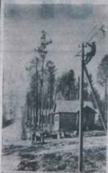
Иркутская область. На левом берегу Анжары, где недавно шумела тайга, создается поселок строителей Братской ГЭС «Постоянный». Здесь уже выросли кварталы жилых домов. В квартирах проводится водопровод. Дома строителей и улицы поселка электрифицируются. НА СНИМКЕ: электрификация улицы в новом квартале поселка «Постоянный».
