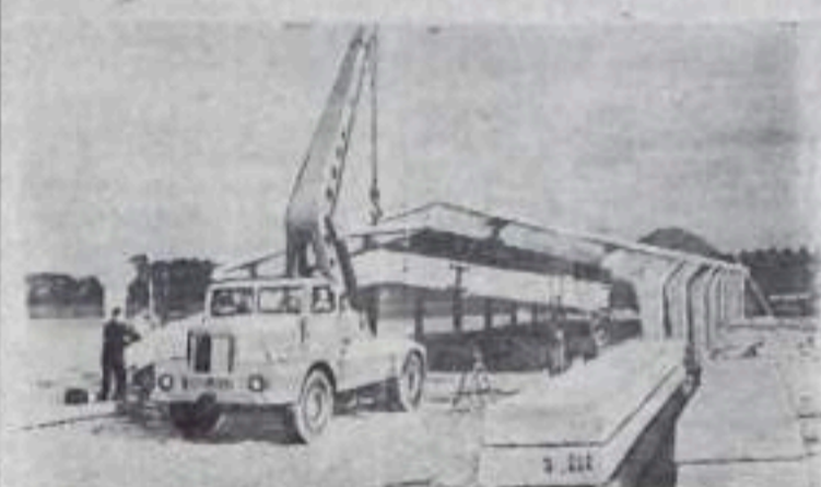
В сельских районах Германской Демократической Республики ведется опытное строительство крупных типовых жилищно-водческих ферм. Фермы сооружаются из крупных бетонных блоков, изготовляемых предприятиями ГДР. Массовое строительство типовых ферм начнется в 1957 году.
