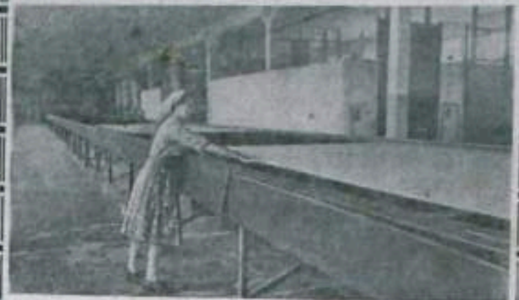
Ленинград. Коллектив Дубровского демонстрационного комбината обязался к 40-й годовщине Великого Октября выпустить 2,23 стандартных жилых «двокомнатных» трехкомнатных домов. К первому сентября уже выпущено 1,677 таких домов. На снимке: в форматном отделении цеха деревообрабатывающих плит. У транспортера — старшая формовщица М. Зубаткина.
