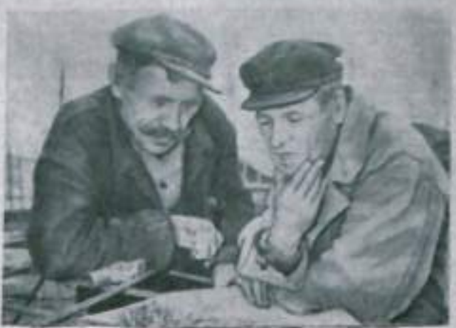
На строительных объектах бригады бригадир Иван Лукин и Иван Прошин (справа) обсуждают график на следующий день. Фото В. Михайлова.
