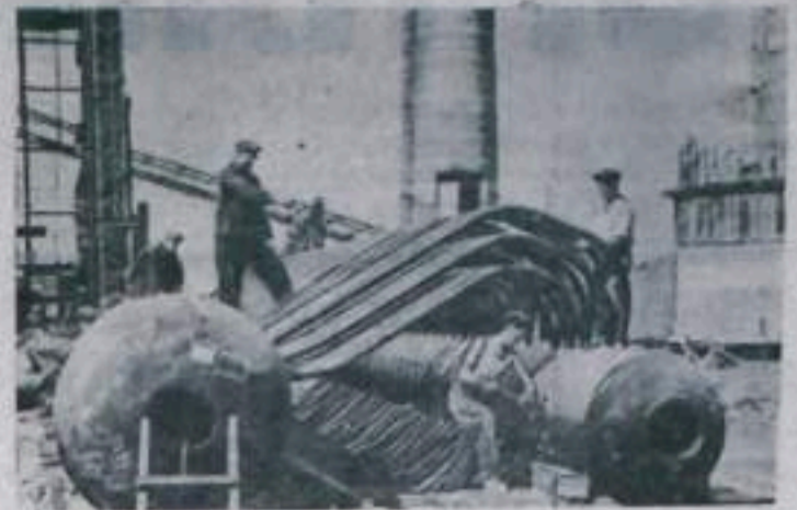
Узбекская ССР. Работники строительной крупнейшей в Средней Азии Ангреновской ГРЭС соревнуются за досрочный пуск первой очереди станции. Монтажные приступили к сборке котла. На этой работе выделяется бригада Л. С. Святицкого. Производственное задание она выполняет на 150—160 процентов.
