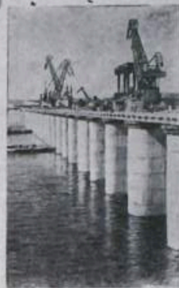
Каховский гидроузел. Водосливная плотина.
