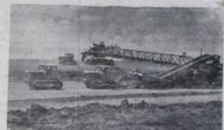
ХЕРСОНСКАЯ ОБЛАСТЬ. Коллектив «Укрводстроя» сооружает Краснознаменский канал. Завершены работы на участке головных сооружений по пригону в канал воды из Каховского моря, ведется «зетирование» откосов канала. На втором участке рытье канала производится при помощи грейдера-струга. НА СНИМКЕ: грейдер-струг на сооружении Краснознаменского канала.
