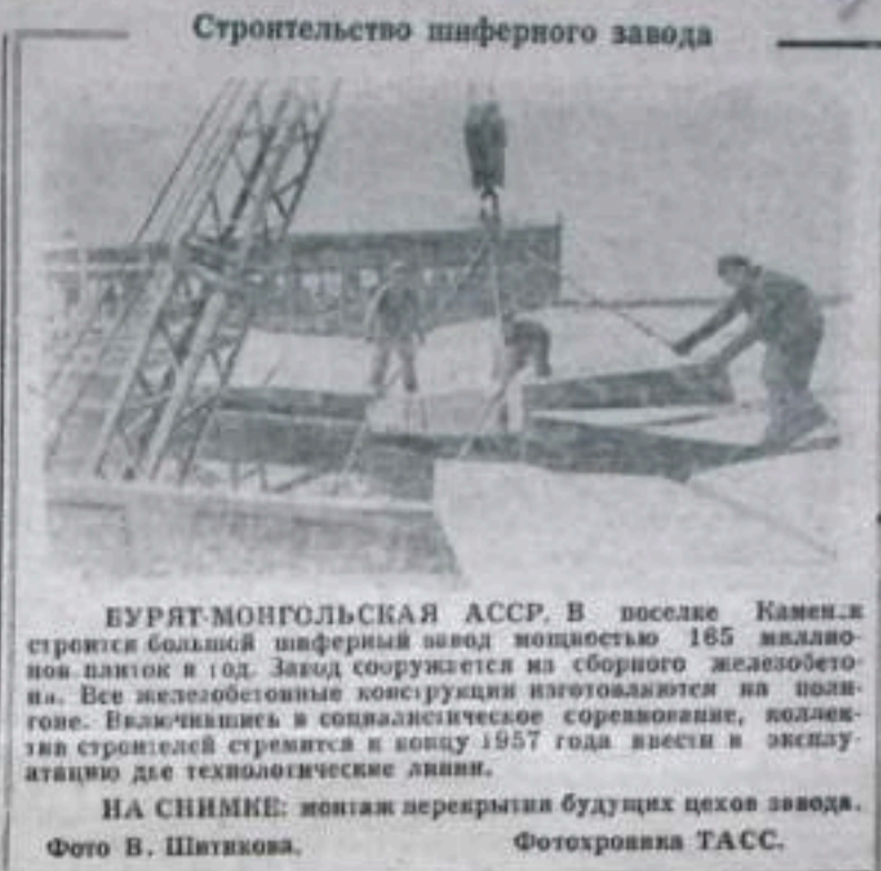
Строительство шиферного завода
