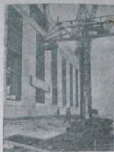
КЕМЕРОВСКАЯ ОБЛАСТЬ. Приближается срок пуска первой очереди своей мощнейшей в Сибири Томусинской ГРЭС. Монтеры собирают главный корпус из крупных шлакоблоков.
