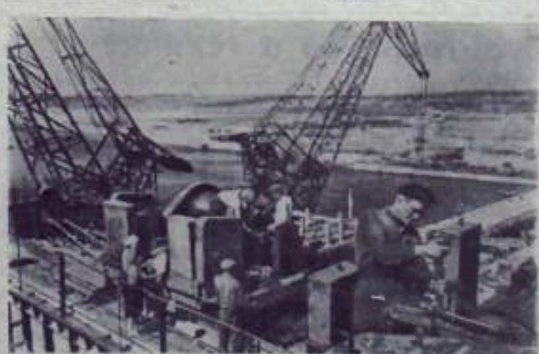
Иркутская область. Строители Иркутской ГЭС борются за выполнение своего обязательства — дать промышленный ток в этом году. После перекрытия русла Ангары вода пошла через аланне ГЭС. Ведется демонтаж наклонного моста, отсыпка русловой и левобережной плотины. Закончено бетонирование подгенераторного массива первого агрегата, бетонруются промежуточные бычки водосбросов на 1 и 2 агрегатах. Идет монтаж мостового крана. На СПИМКЕ: передовая бригада монтажников А. Шайкина за монтажом первого мостового крана грузоподъемностью в 310 тонн. На переднем плане — монтажник В. Саленко.
