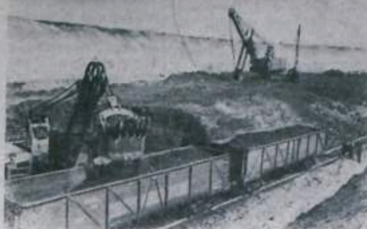
Иркутская область. Трест «Черемховуголь» за год и девять месяцев, значительно раньше установленного срока, построил и сдал в эксплуатацию семь угольных разрезов с технологическими комплексами и подсобными предприятиями, а также большое количество жилых домов для рабочих. Добыча угля в разрезах осуществляется с помощью новейшей мощной техники.
