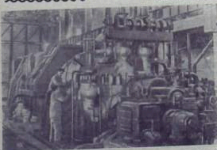
УЗБЕКСКАЯ ССР. В окрестности Ферганы развирнулось строительство нефтосерафинировочного завода. Это — одна из крупнейших новостроек республики. Закончено строительство первой очереди ТЭЦ. В короткие сроки были сооружены уютный склад, химводоочистка, градирня и другие вспомогательные помещения.
