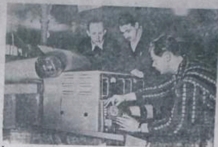
ЛЕНИНГРАД. Коллектив завода «Геогоразведка» изготовил для Антарктической экспедиции Академии наук СССР аэрогеофизическую станцию комплексного типа «АСПМ-25», предназначенную для разведочных работ с воздуха. Она монтируется автоматически на летательном аппарате, производится на самолете. Запись показаний аппаратуры производится автоматически на ленте. Новая станция обладает высокой чувствительностью. НА СНИМКЕ: (справа налево) настройщик А. К. Шонель, механик В. В. Иванов и бригадир радиомонтажников А. А. Житков за настройкой новой станции. Фото А. Михайлова. Фотохроника ТАСС.
