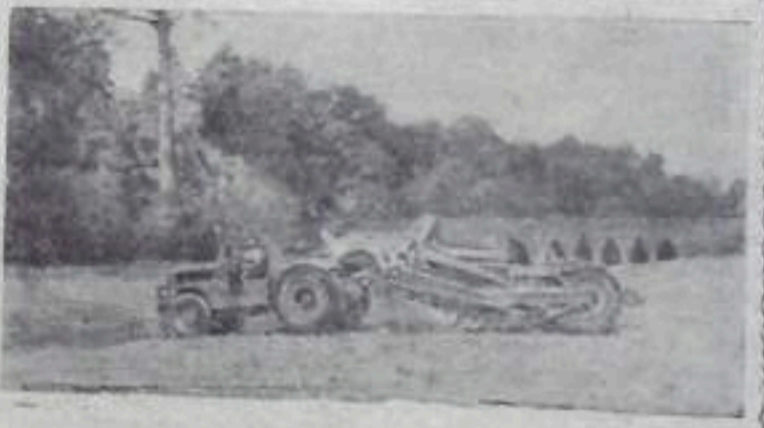
КАМБОДИЯ. Строительство оросительной системы в провинции Спек-Кеал.
