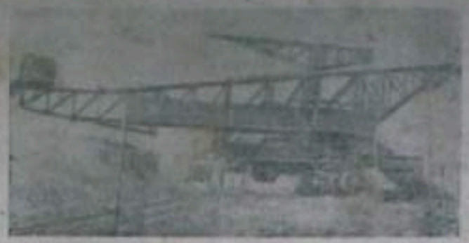
В этом году в Кумертауском разрезе введена в эксплуатацию самая мощная горная машина — экскаватор ДС-1500. Эта машина предназначена для вскрышных работ. При электровозной откатке она может погрузить в думпкары до 1800 кубометров грунта в час.
