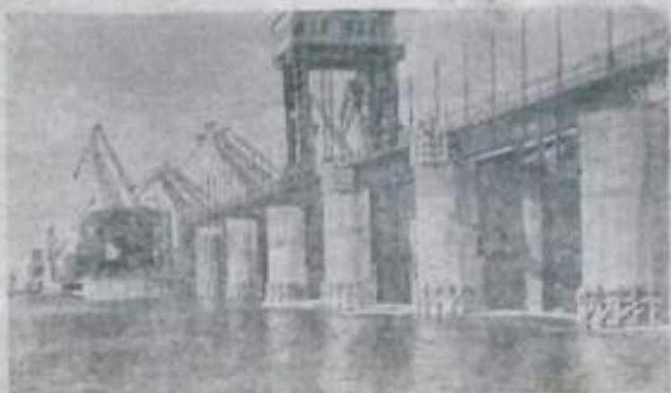
НА СНИМКЕ: строительство Новосибирской ГЭС.
