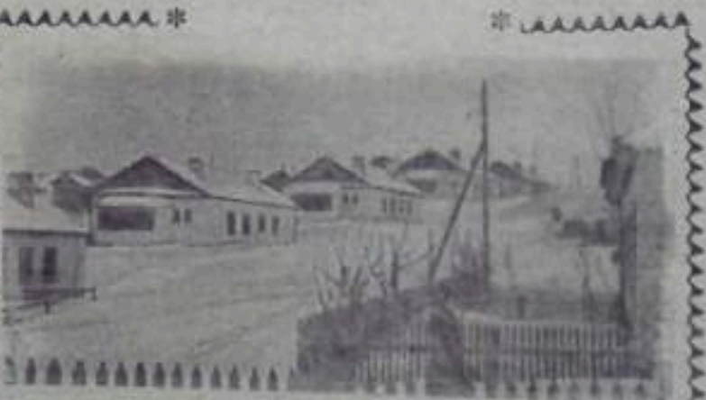
Оренбургская область. В городе Медногорске, где распланирован крупнейший на Южном Урале жилищный комплекс, строится многоэтажный дом. Наряду с государственным строительством возводятся дома силами трудящихся. Недавно рабочий коллектив закончил сооружение десяти двухквартирных домов, где поселились сами строители — рабочие цеха калибровки.
