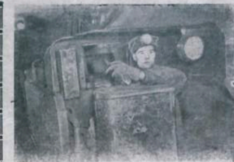
Пермская область. Коллектив шахты №41 «Капитальная» треста «Коспашуголь» комбината «Кизелуголь» сверх плана 1957 года выдал 10 тысяч 300 тонн угля. Горняки внедряют новаторские приемы труда в проходческих работах. Усиленные бригады, они довели проходку основных выработок штреков до 180 метров в месяц. НА СНИМКЕ: передовой машинист элеватора К. П. Белогубкин в штреке. Фото А. Стужина и Б. Визула. Фотохроника ТАСС.
